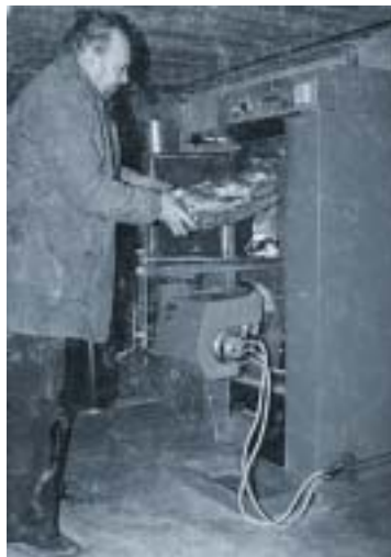
Fig. 27 – Operazione di caricamento di una caldaia a tronchetto.
